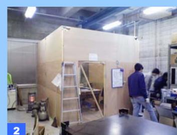
2. FRP 成型・塗装室の全景。屋外への掃気フロアを設置し、室内を負圧に保つことで粉塵の漏れをシャットアウトする。
